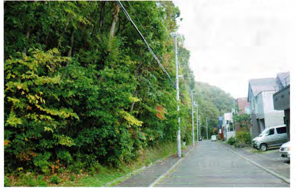
真栄4条1丁目の札幌市所有のがけ地と住宅地
