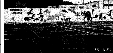
庁舎建設工事のための駐車場板囲い
