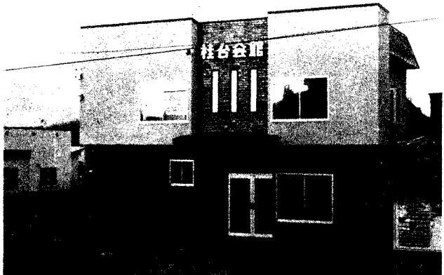
会館名 桂台会館 所在地 里塚 792-1 構造 鉄骨 1部木造 2階建 集會室 165.7㎡ その他 63.4㎡ 計 229.1㎡
