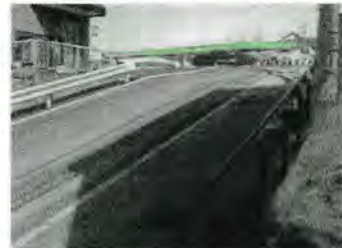
完成道路風景
